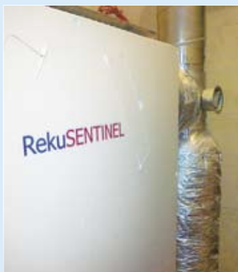
Rekuperator ze zwrotnicą pozwalającą na przełączanie korzystania z czepni ściennej i z GWC
