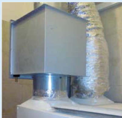
Nagrzewnica kanałowa (o mocy 1000 W) i tłumik akustyczny
