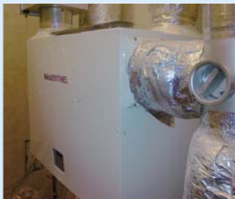
Centrala wentylacyjna z przeciwbieżnym wymiennikiem ciepła
