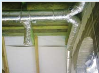
Rozprowadzenie kanałów na poddaszu, nawiew do salonu i sypialni
